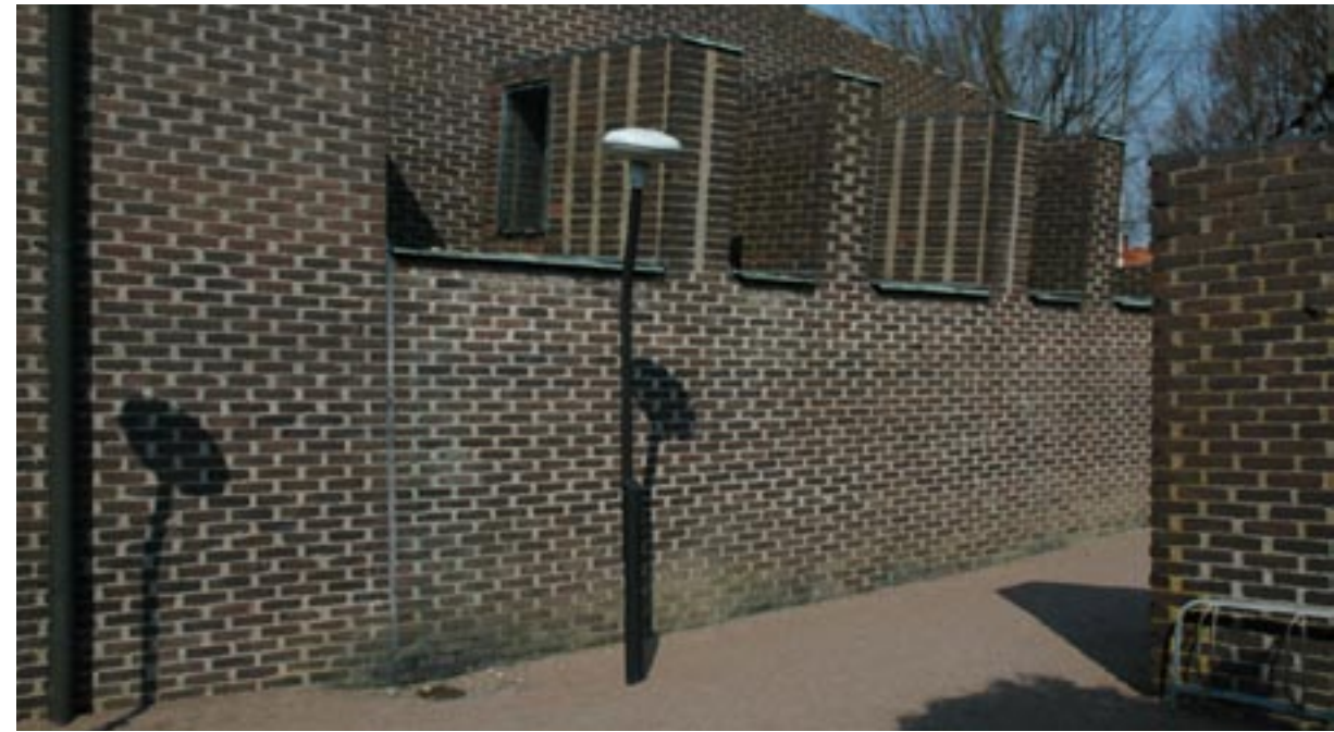
Den svenske arkitekt Sigurd Lewerentz' dogmatiske arbejdsgang med kun at ville anvende hele teglsten i sit byggeri, lader stenen træde i karakter og giver blandt andet udslag i afvigende brede studsfiger i en skalmur med halvstensforskuet løberskifte. S:t Petri Kirke, Klippan 1966. FOTO: KJELD VINDUM
