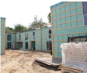
Byggeproces Fotos: CINARK
