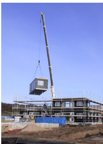
Præfabrikerede volumenelementer Foto: Tegnestuen Vandkunsten
