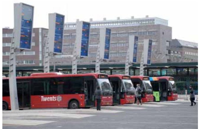
Busterminalen, hvor skiltingen optræder som skulpturer. Busterminalen ligger i umiddelbar forbindelse med stationen. De høje bygninger i baggrunden er en del af fortætningen omkring stationen.
