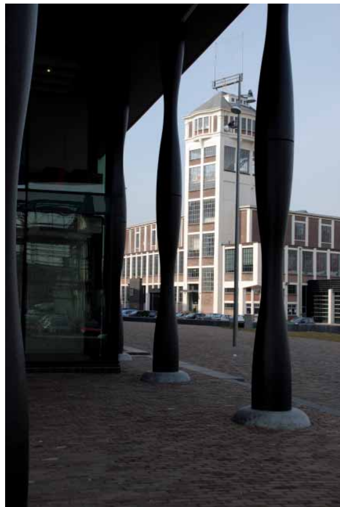
Brandstationen set fra forarealerne til uddannelsescentret. Jernbanen ligger umiddelbart bag brandstationen.
