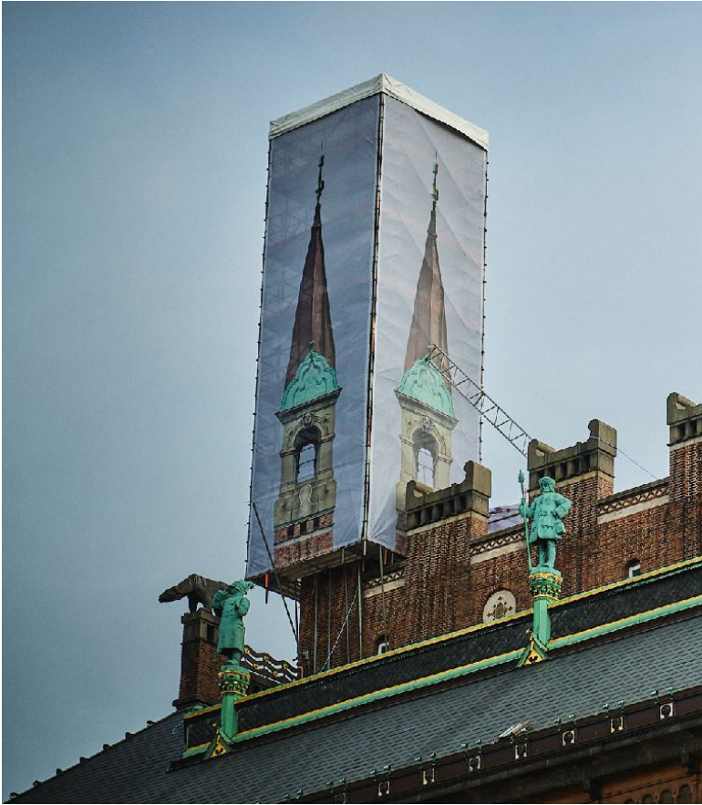
Eksperiment 2021 med ombygning af sidespir og print på byggepladsens stillads.
