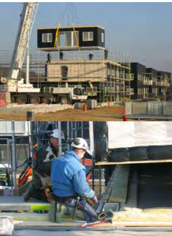
BoKlok. Montage af bygningselementer Foto: Kasper Vibæk Jensen
