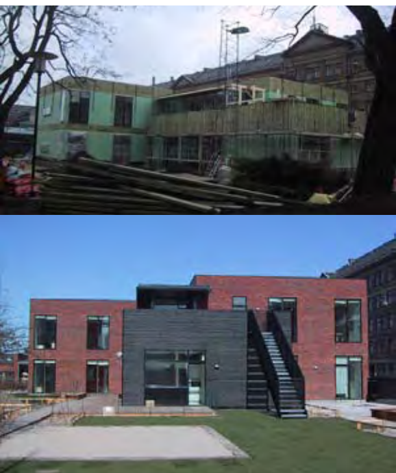
ONV, Institution i Møllegade. Billeder fra hhv. under opførelse og det færdige byggeri
