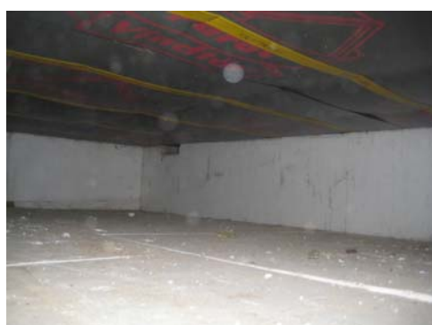
Figur 97,98, 99 Lem til krybekælder 100mm polystyrenisolering på jord og fundamenter. Åbning i fundament til næste bolig. Ophængt HOBO.
