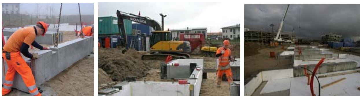
Figur 7, 8, 9 BoKlok i Måløv. Præfabrikerede kantfundamentsbjælker på punktfundamenter, isolering og installationer under volumenelementerne
