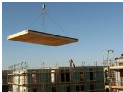
Figur 28 Montering af dækelement
