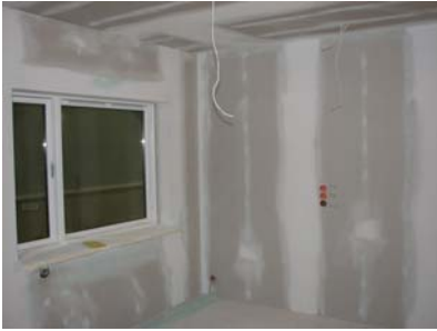
Figur 18 Installationer og gipsvægge
