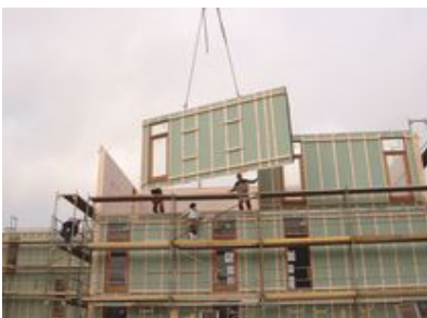
Figur 27 Montering af facadeelementer
