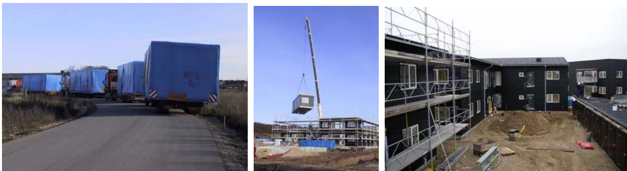
Figur 31, 32, 33 Volumenmoduler transporteres, hejses på plads og samles
