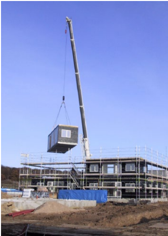
Præfabrikerede volumenelementer Foto: Tegnestuen Vandkunsten
