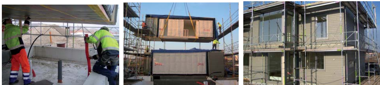
Figur 34, 35, 36 Montering af BoKlok rækkehusene i Måløv
