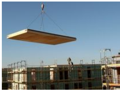
Figur 27 Montering af facadeelementer
