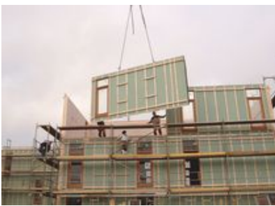
Figur 27 Montering af facadeelementer
