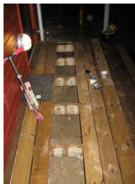
Figur 92 Terrassebrædder fungerer som ventilationsrist
