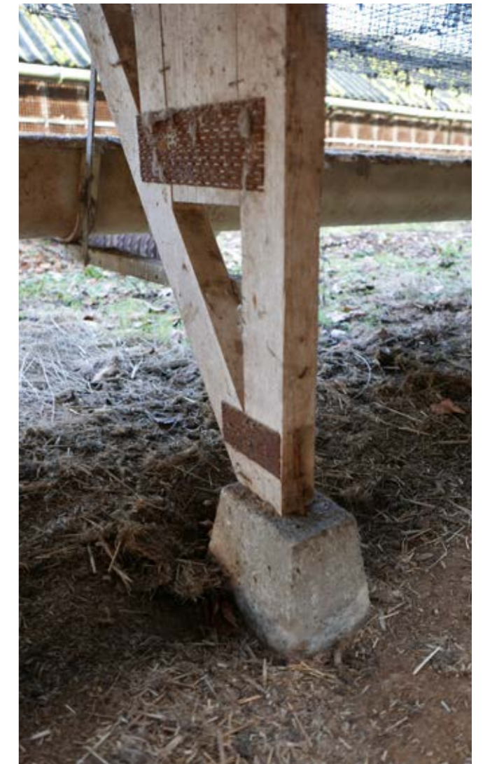
Minkhallenes betongfotter, Tranekær gård. Eget foto.
