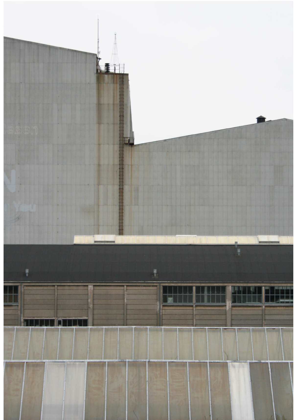
De mange forskellige industribygninger fra forskellige tider. Kilde: Eget foto
