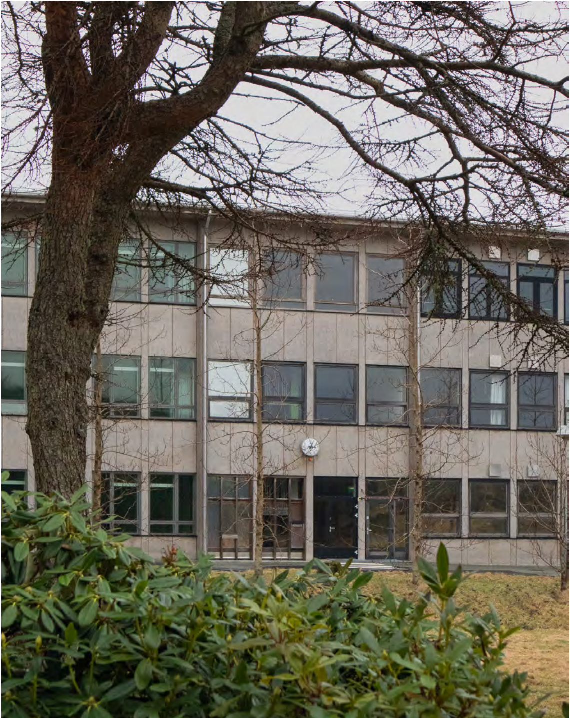
Foto Facaden før
