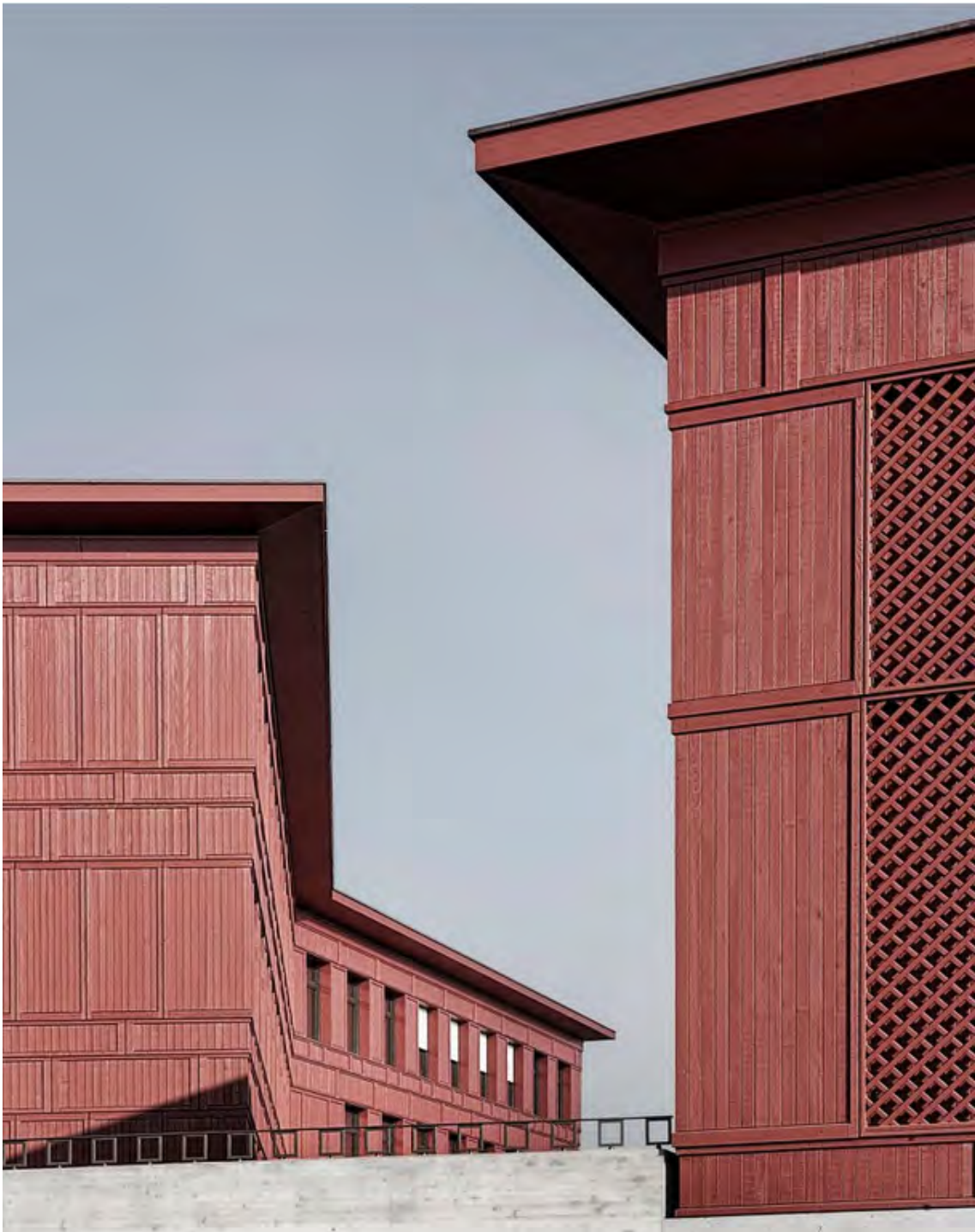
Fiechter & Salzmann Architekten Erweiterung schulhaus ballwil
