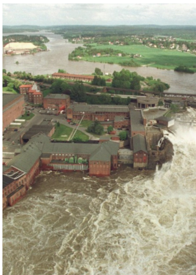
Borregaards fabrikksovråde 1995. Her ses vannbassenget øst for bygningen. I 2010 ble den siste fabrikk langs elven revet.
