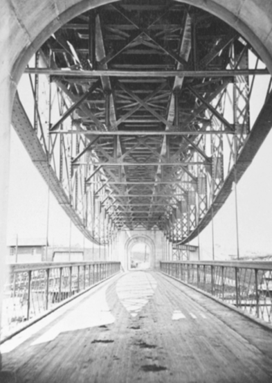
Broen fra ---. Sett fra kjørebanelen fra vestre hovedpilar
