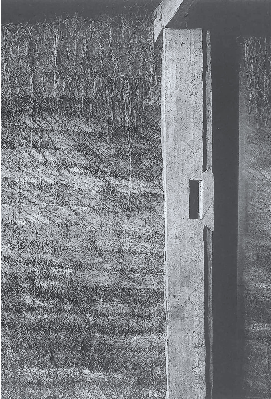
Væg af strengur og tømmer genbrugt fra andre bygninger. I forhallen ved tørvegården Stóru- Akrar i Skagafjörður
