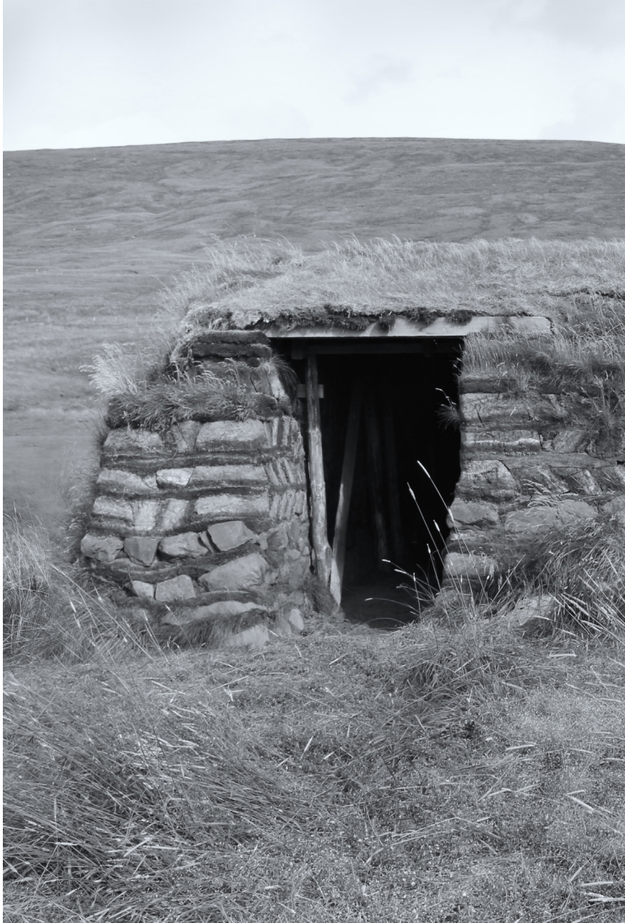
Eksempel på hvordan et nedslag kunne se ud: Funktionstømt tørvehus med klambra vægge ved Tyrfingsstaðir Fjárhúsin.
