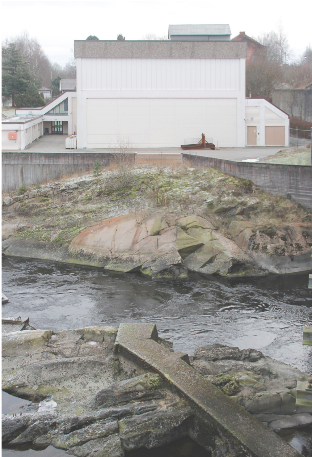
Over: Sarp kraftverk sett fra gangbroen Til høyre: Snitt gjennom aggregatene til Sarp kraftverk
