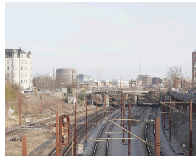
Kig ud over banelegemet. Grunden ses til venstre og KAB-huset til højre.
