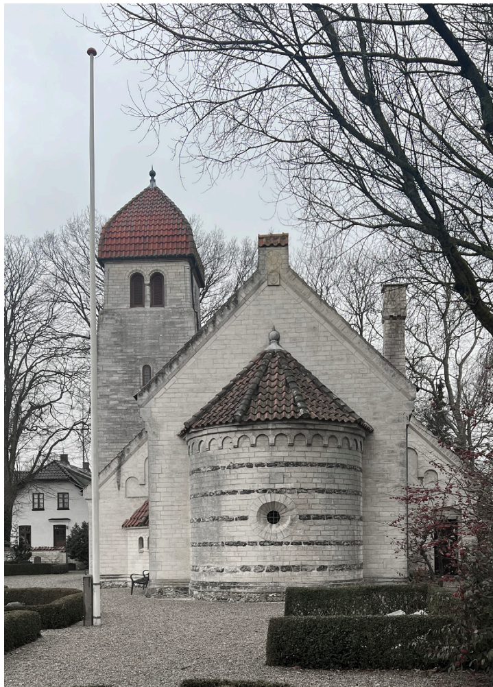
3. NY HØJERUP KIRKE Opførelsesår: 1912-13 Arkitekt: Helge Bojsen Møller Bevaringsstatus: Fredet Anvendelse: Kirke
