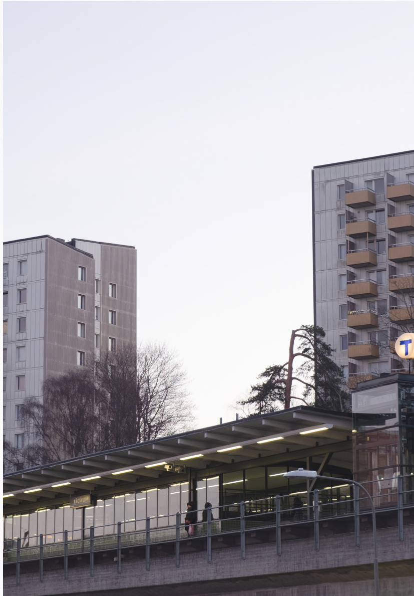
Metrostationen set fra Rågsvedsvägen
