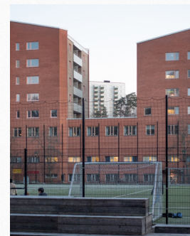
Seniorboliger og kommunal service Opført 1982
