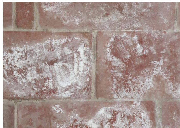
Forhøjet grundvandsspejl skaber oversvømmelse i kælderen og efterlader et saltlag. En rende skal lede vandet væk. Egne fotos.
