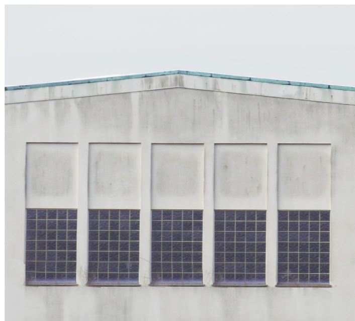
Facade mod øst. Recesser markerer de oprindelige vinduers placering. Glasbygningningsstenen er tilføjet for at hindre indkig i sendersalen. Det karakteristiske saddeltag markeres med en vindskede af kobber. Eget foto.
