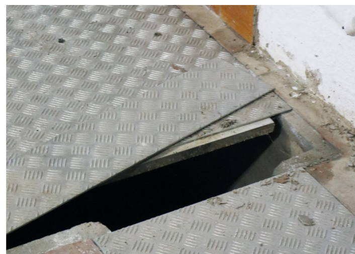
Forhøjet grundvandsspejl skaber oversvømmelse i kælderen og efterlader et saltlag. En rende skal lede vandet væk. Egne fotos.
