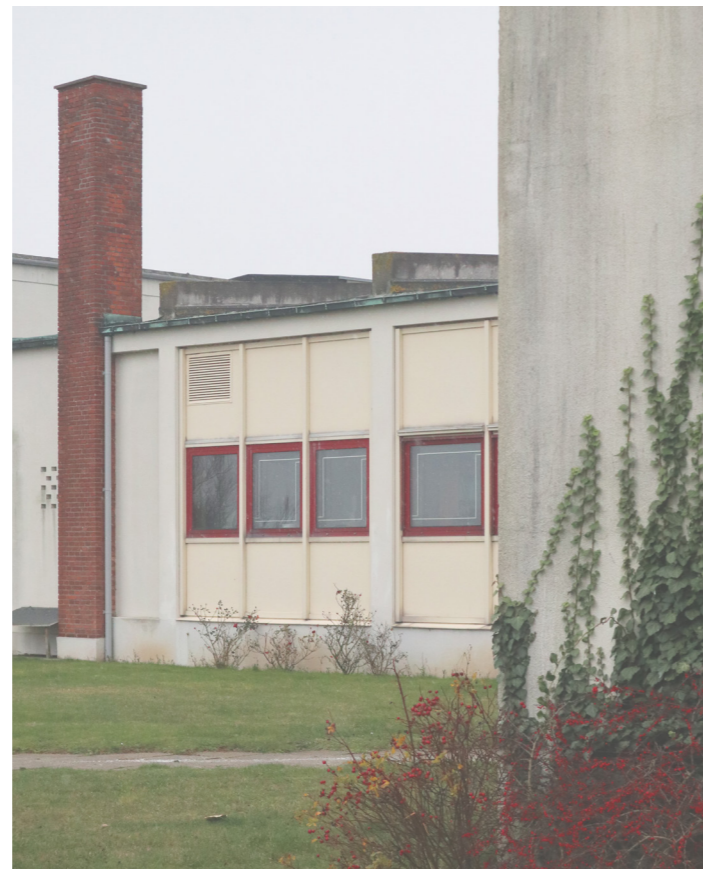
Østfacade med 80'ernes indgreb på facadeudtrykket. Eget foto.
