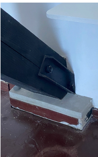
Det støbte fundament jern profillet der fæstner saksespæret, eget foto 2022.
