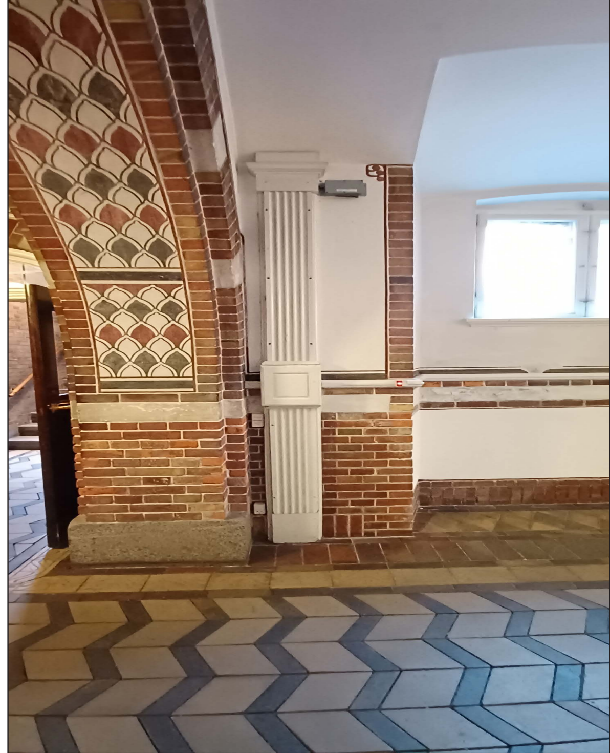
Københavns Rådhus, Martin Nyrop, Installationssøjle
