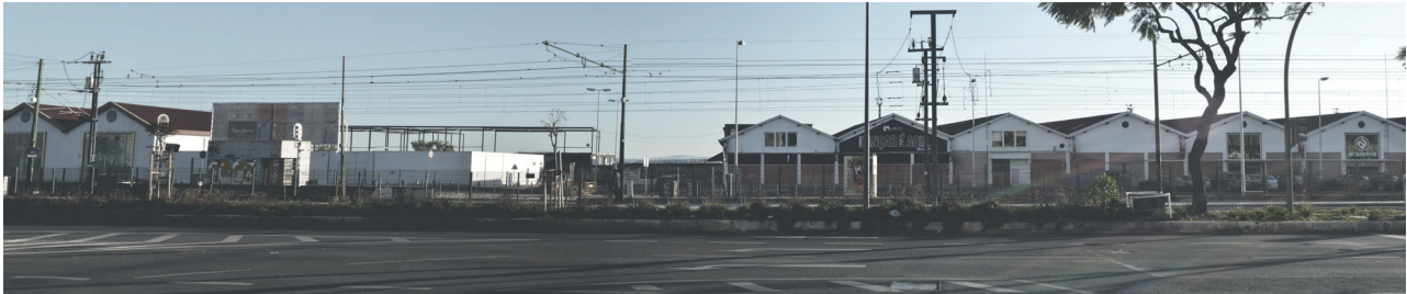
Siteområdet set til venstre, i midten ses indhakked efter der hvor Av. Dom Carlos I engang fortsatte over jernbanen
