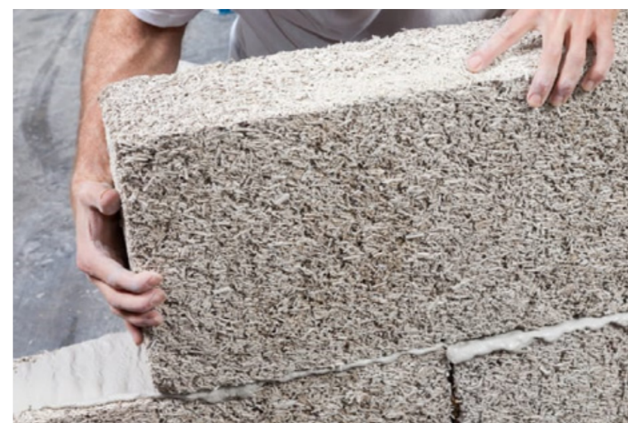
Hempcrete (som efterisolering på gavle)
