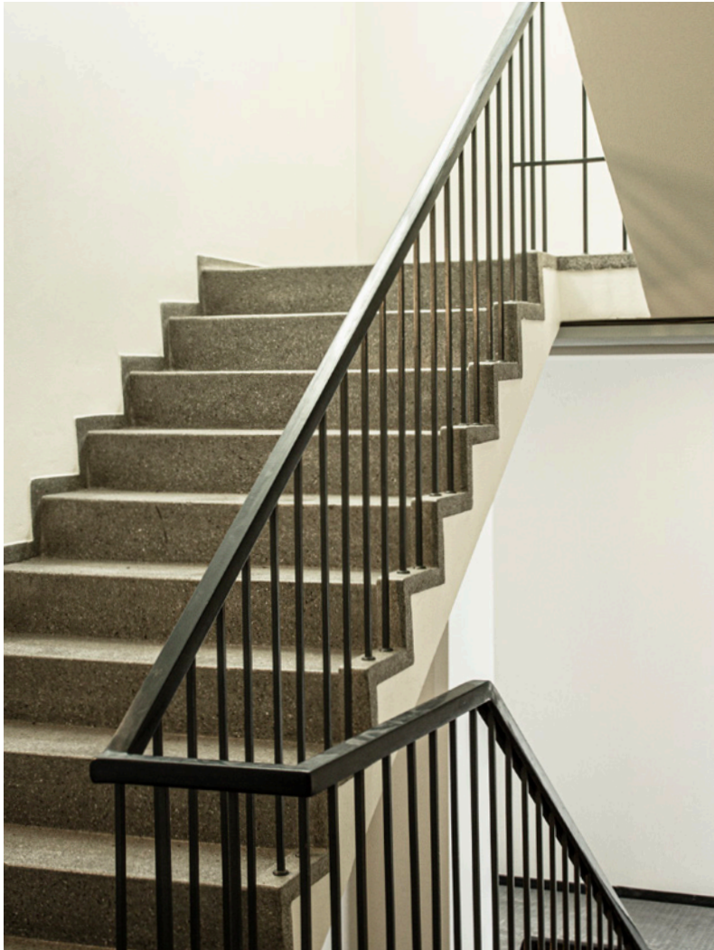
Trappeopgang med terasso gulve
