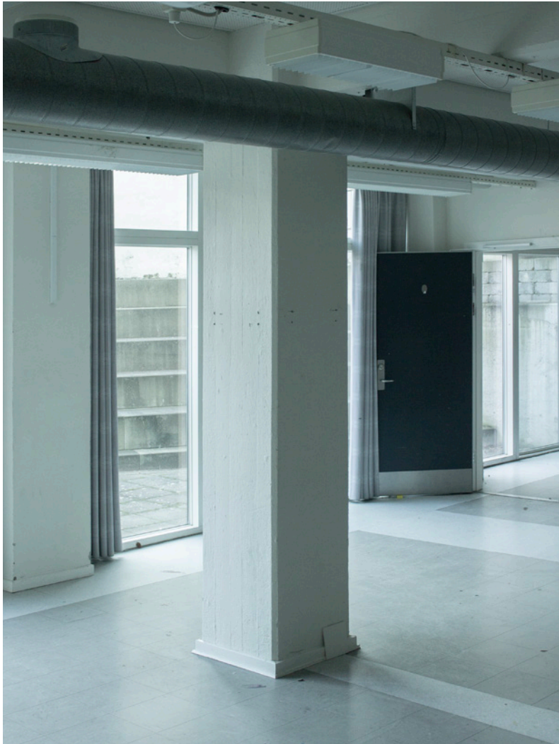
Kælderkonstruktion fra 1960 Ventilation
