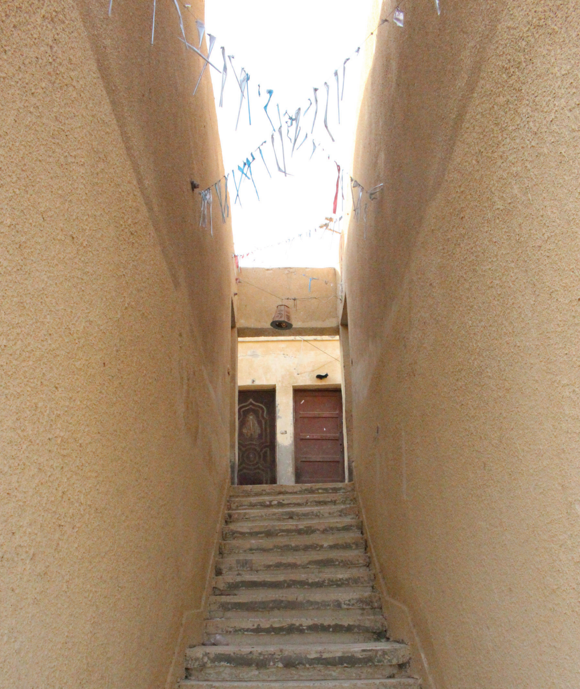
Billedet illustrerer den udvendige trappe, der fører op første sal og baggården.
