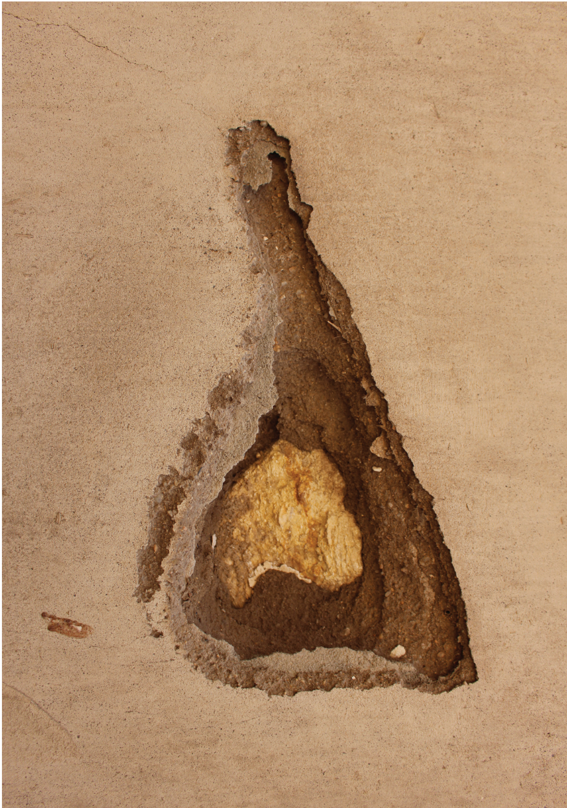
Billedet illustrerer bygningens lag af porøse materialer. Her er der taget et billede af bygningens pudsede væg, hvor nogle af de indvendige lag af kalksten og ler er kommet til syne.
