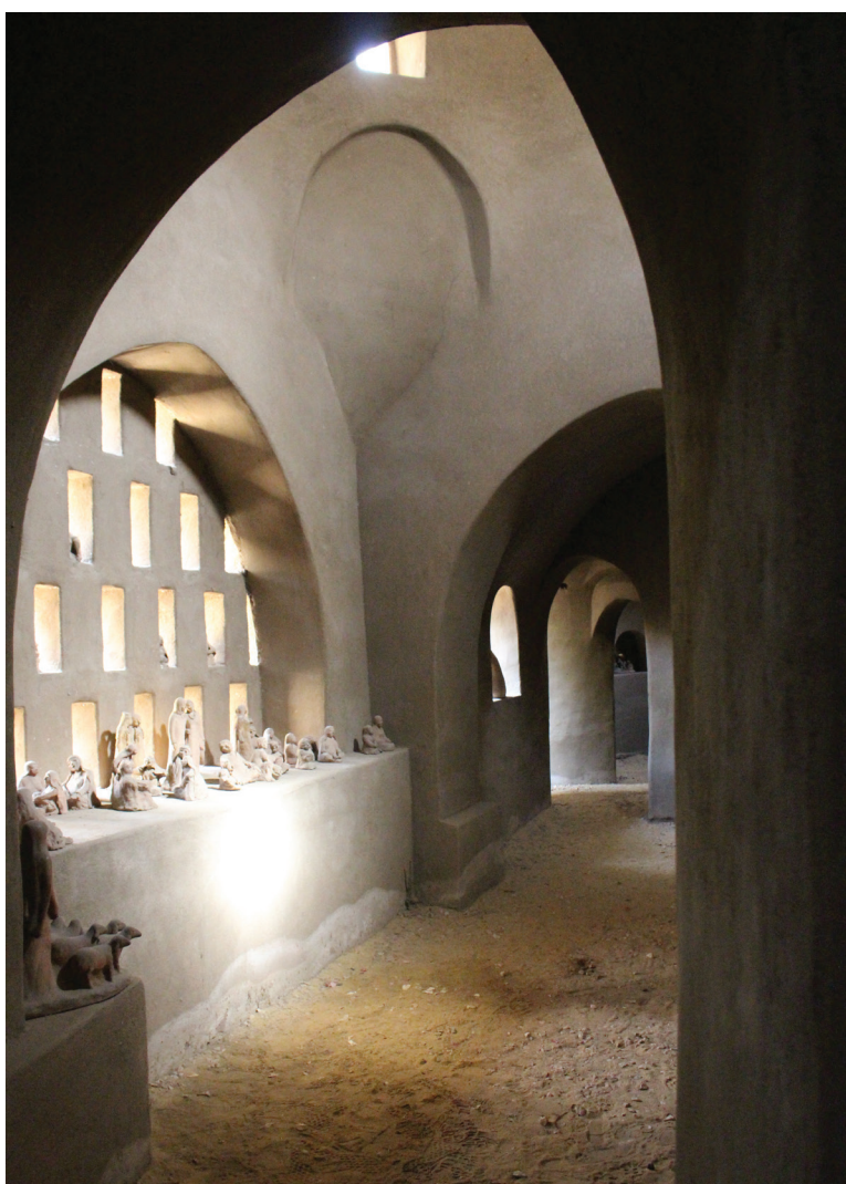
Billedet illustrerer de luft- og lysskakter som er blevet etableret i skulptur udstillingsrummet. De fungerer både som et naturligt spotlys for de keramiske elementer, samt som et luftcirkulations system.
