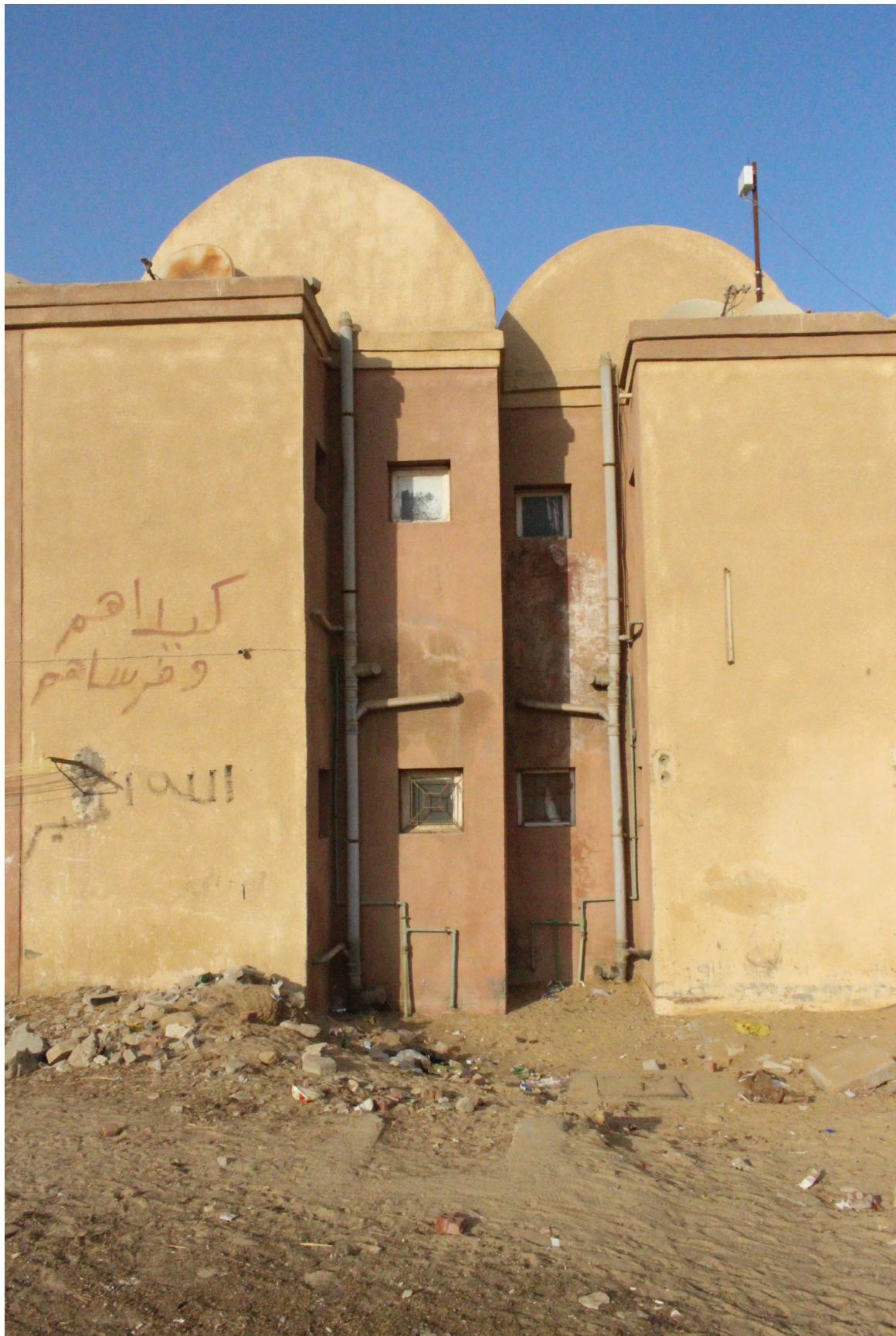
Billedet illustrerer hvælvingernes brug som gavlelementer i Haram City.
