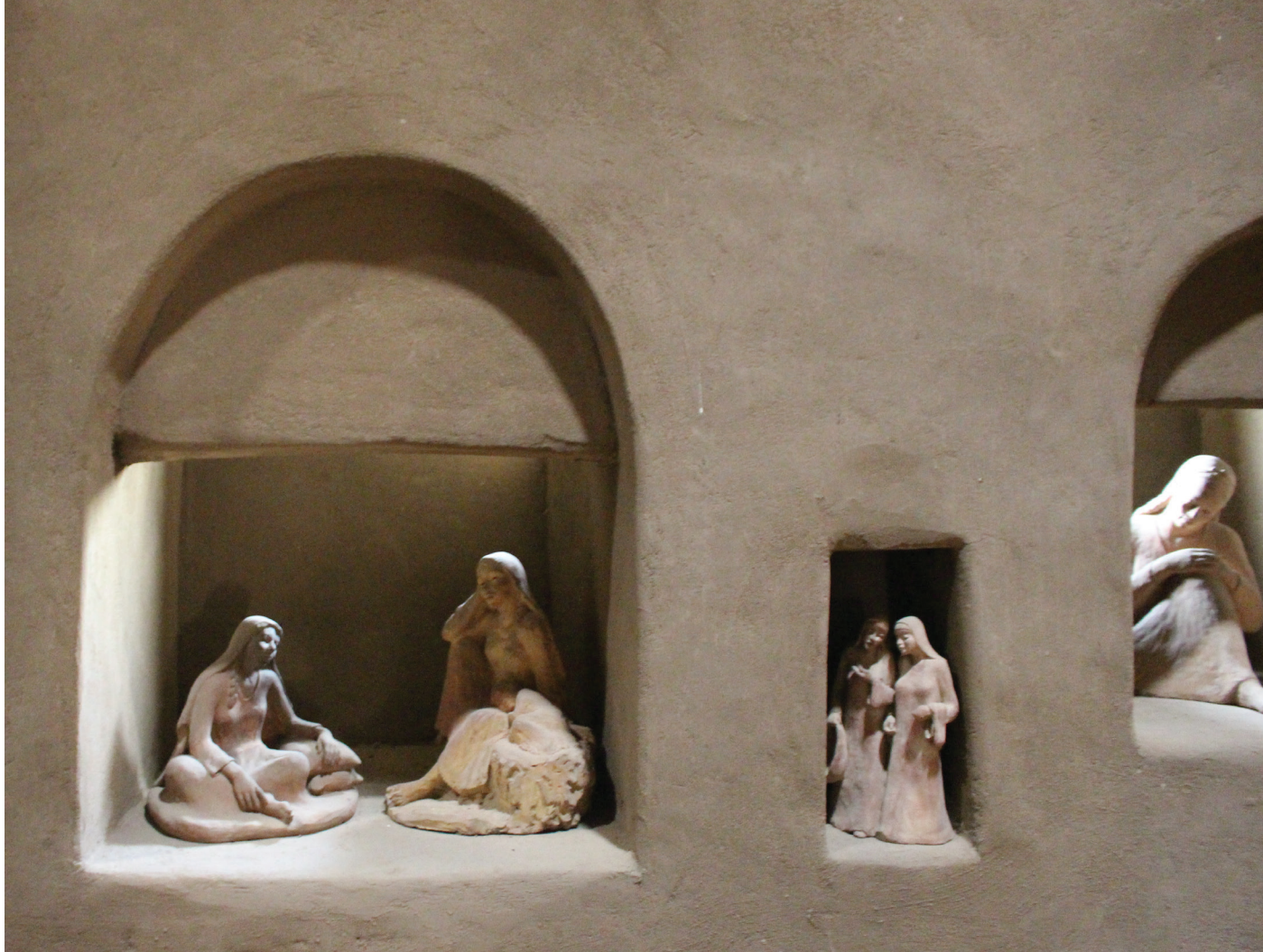
Billedet illustrerer de luft- og lysskakter som er blevet etableret i skulptur udstillingsrummet. De fungerer både som et naturligt spotlys for de keramiske elementer, samt som et luftcirkulations system.
