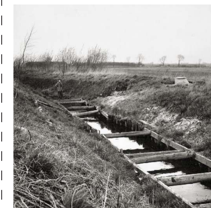
I 1955, over 150 år efter første tørlægning, var søbunden stadig så blød og dyndet, at afvandingskanalerne måtte afstives for at hindre brinkerne i at skride ud.
