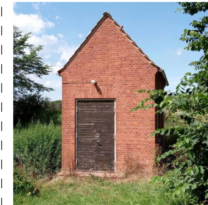
Pumpehus fra 1940'erne
