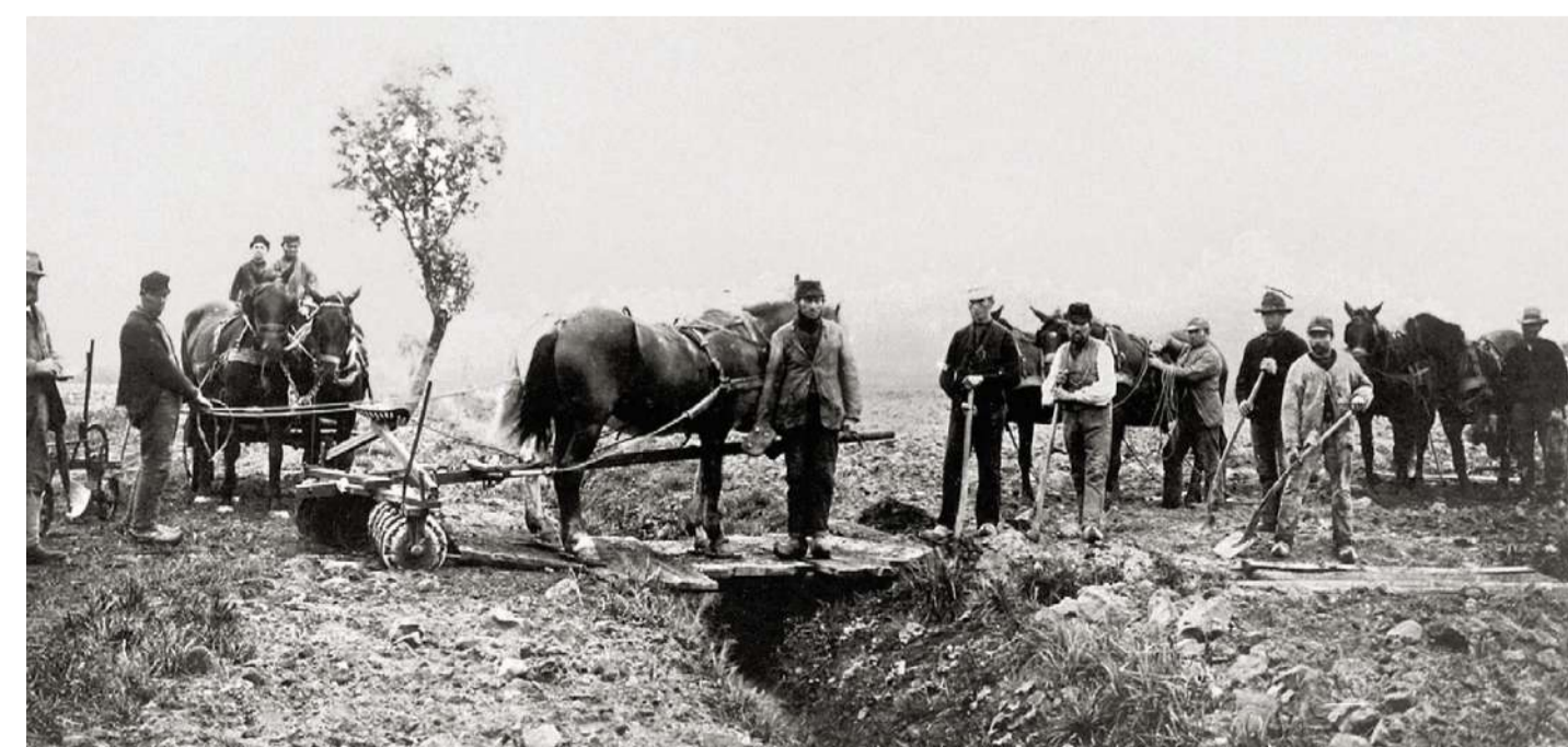
I 1800-tallet blev kanaler og grøfter gravet med håndkraft, i perioder med en arbejdsstyrke på ca. 150 mand
