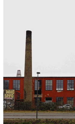
Bygning A, 1952 Fabriksbygning
