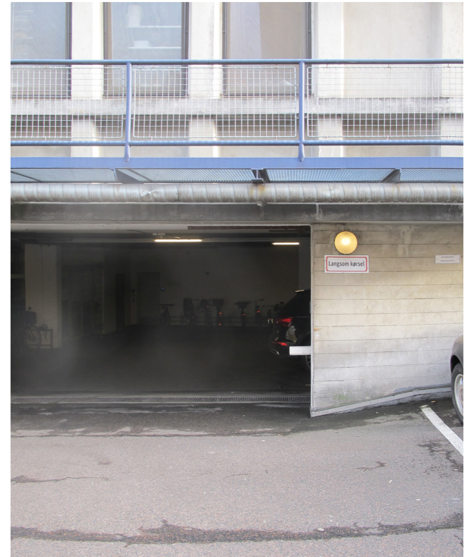
foto inkörsel till parkeringshus från parkeringsplats
