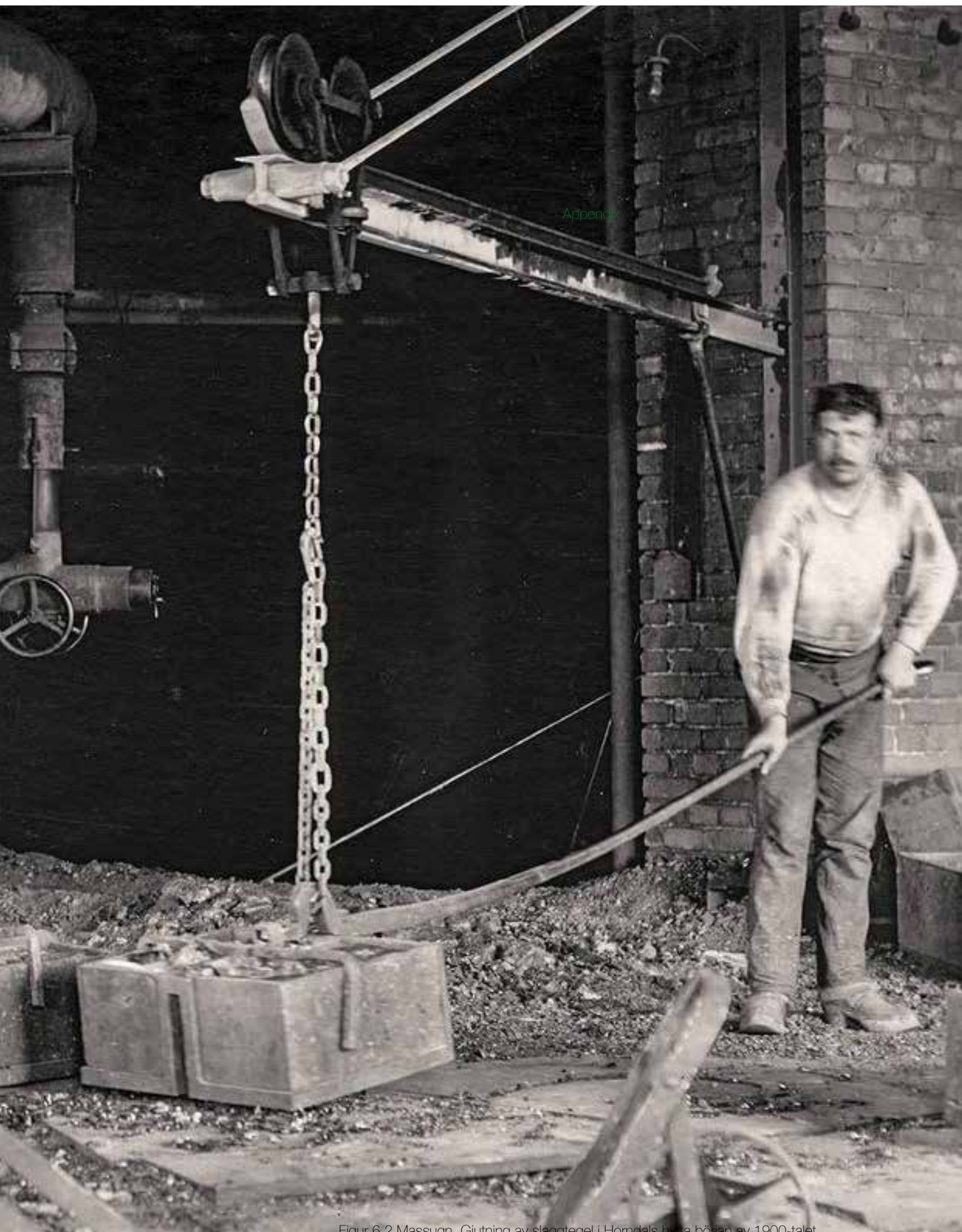
Figur 6.2 Massugn. Gjutning av slaggtegel i Homdals by i början av 1900-talet
