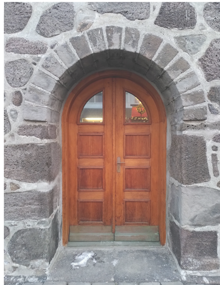
Hovedindgangen af Hegningarhúsið
