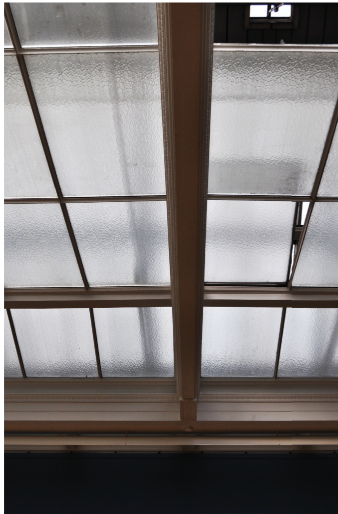
Glasloft Det indre loft - det ydre tag Tillader dagslysets indtrængen i rummet
