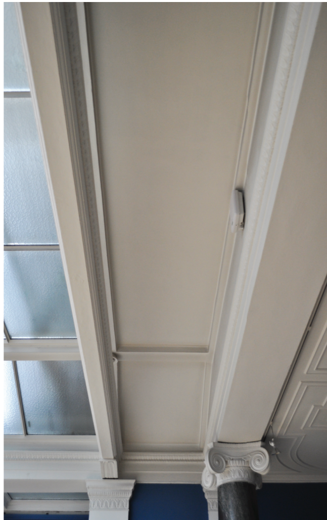
Loft Detalje i overgangen mellem det lave loft og glasloftet
