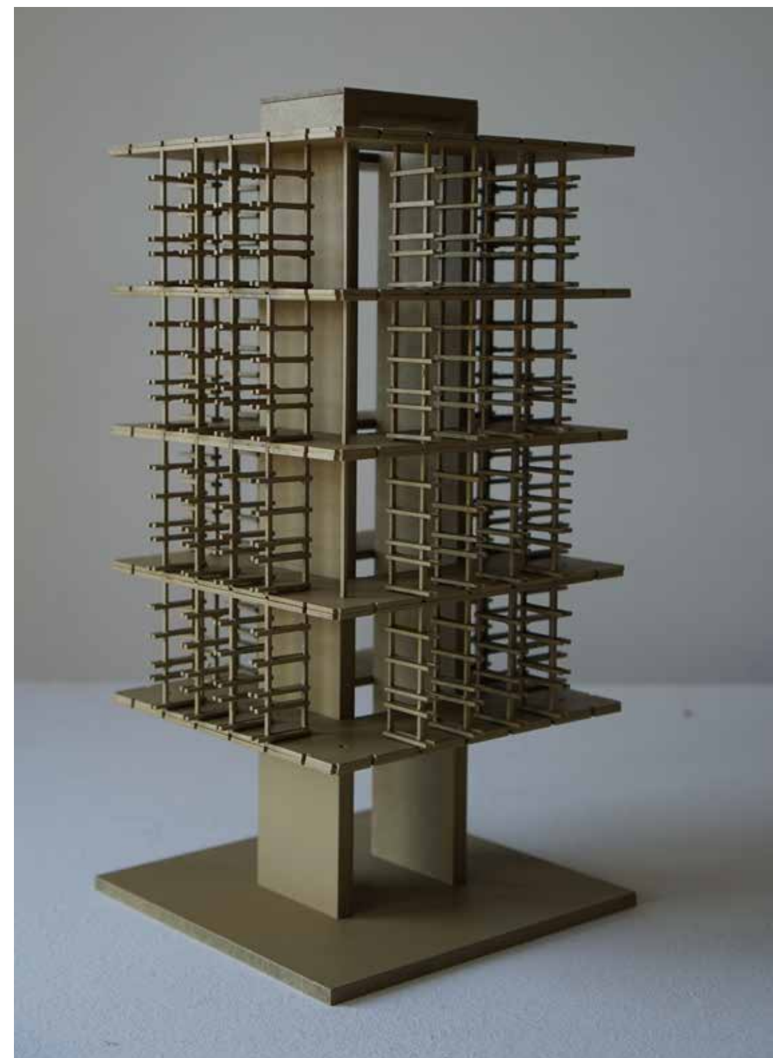
Konstruksjonsprinsipp: Kjernen som bærende element
