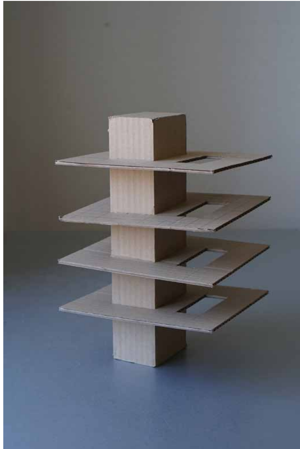
Konstruksjonsprinsipp: Kjernen som bærende element
