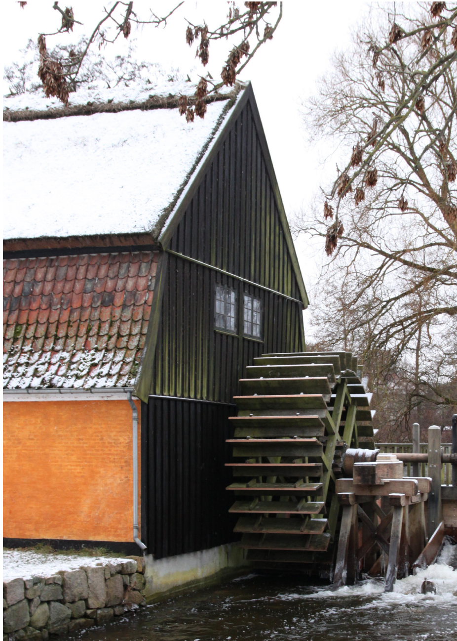
Figur 4 Lyngby Nordre Mølle, opført mellem årene 1846 og 1850, med et brystfaldsvandhjul fra 1851. Møleværket er genopført i 1985 efter opmålingstegninger fra 1915 (Kulturarvsstyrelsen, Rudersdal Kommune et al. 2012).
