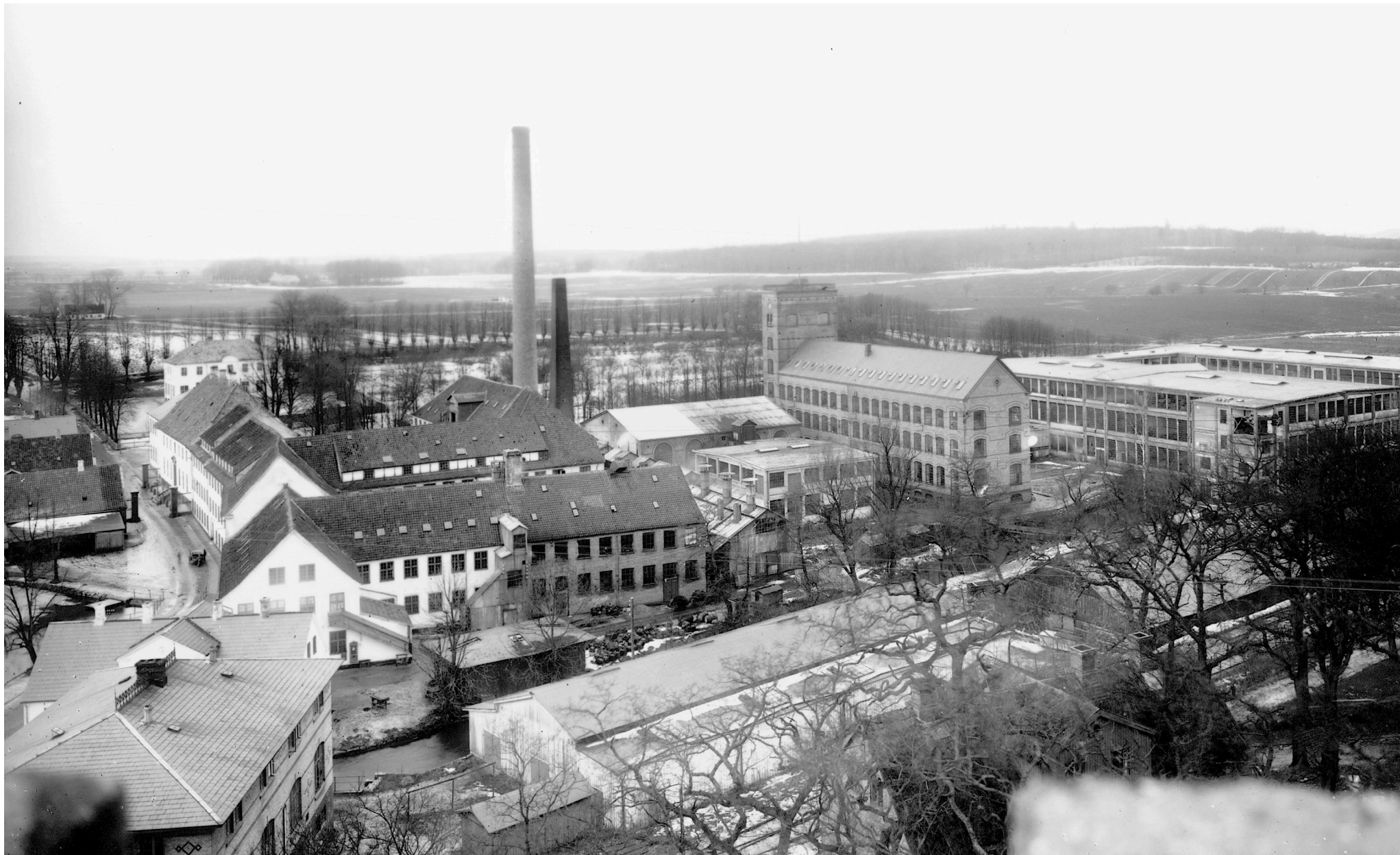
Figur 5 Brede Klædefabrik, set fra vandtårnet år 1920. Brede er et veludbygget og velbevaret fabrikssamfund med produktionsbygninger, arbejder- og direktørboliger, spisehus, vandtårn, gartneri og lysthusbebyggelse mv. (Kulturarvsstyrelsen, Rudersdal Kommune et al. 2012). Frem til 2018 havde Nationalmuseet en fast udstilling på værket om dansk industriekultur, men grundet besparelser er Brede Værk i dag (2021) lukket for publikum (Nationalmuseet).
