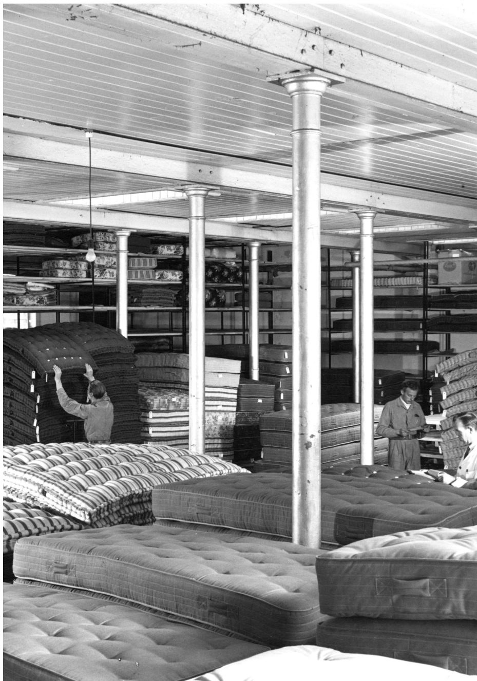
Figur 8 Krøluld-Fabriken Lama A/S - Springmadrasserne kontrolleres. Fotografiet er taget i bygning "M" eller "N", med indvendige støbejernssøjler, kombineret med valsede stålprofiler.
