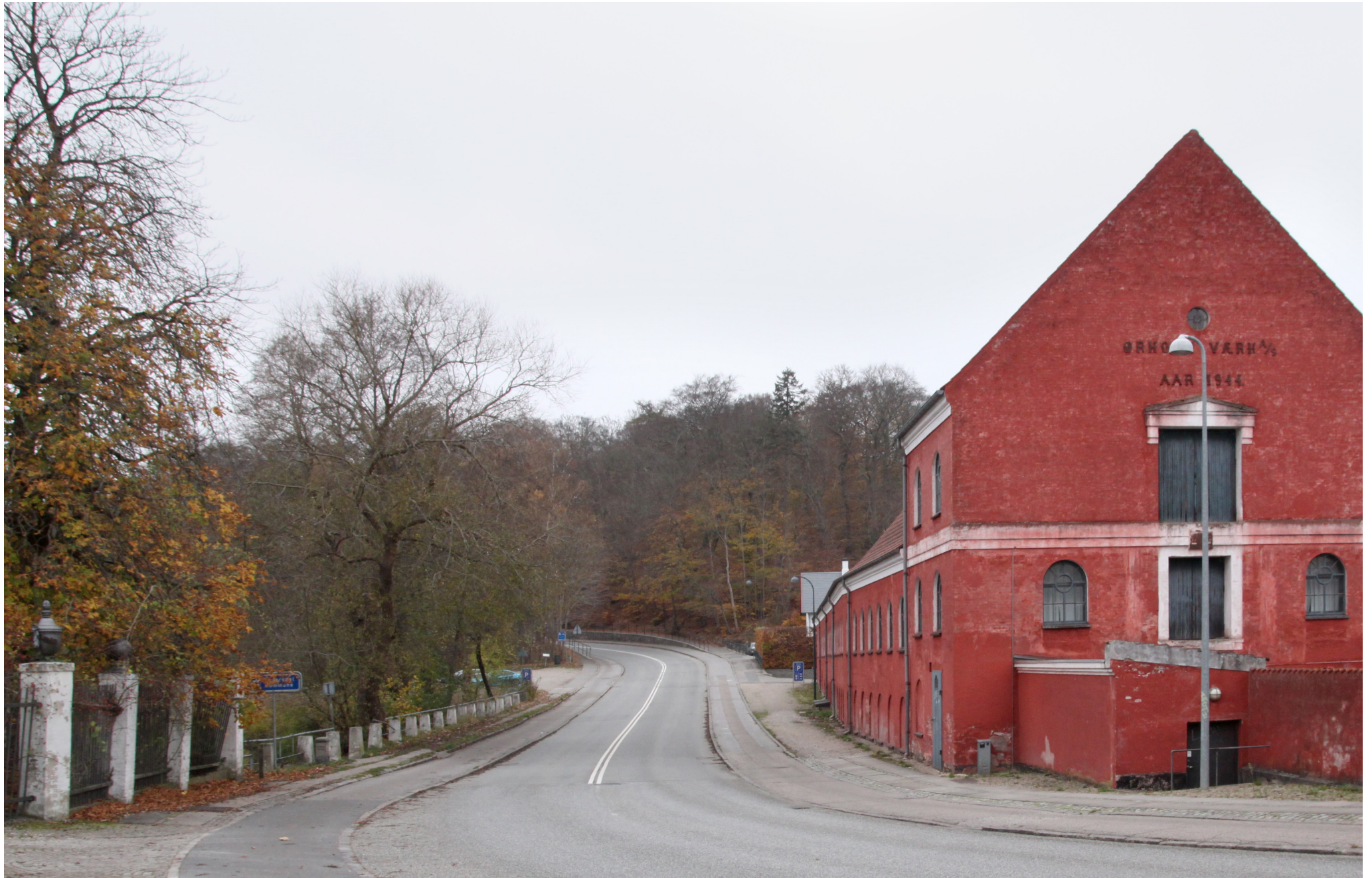
Figur 9 Ørholmvej set mod nord-vest, med møledammen til venstre og værket til højre. Lige ud ses Ravnholm skov - også kaldet "Det danske Schweiz", grundet de stejle skrænter (COWI 2007).
