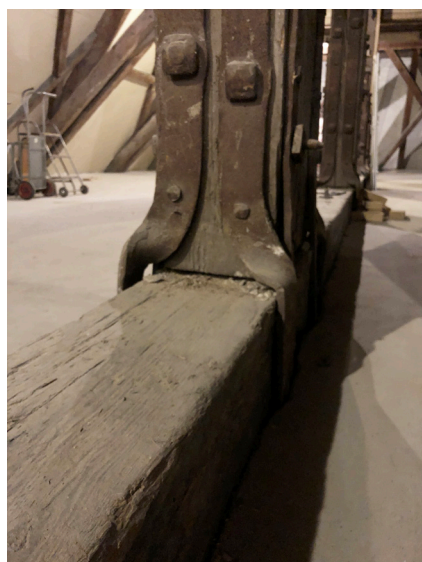
Konstruktionen hvori loft og gulv hænger
