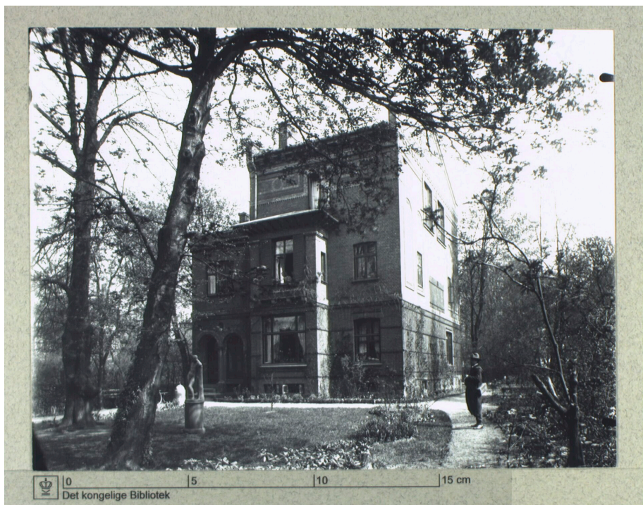
Fotografier fra 1981 af villaen på Rosenvængets Allé 46. Villaen opføres samtidig med, at Dahlerup får opført hans nytegnede udgave af Det Kongelige Teater. Villaen i nr. 46 fremstår næsten som en afskåret del af en større masse.
