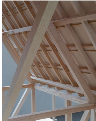
Fig. 27. Timber frame construction, Nicolai Bo Andersen Arkitekt, 2019
