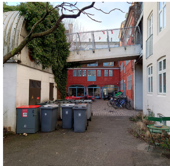
fig 28: gangbro fra vuggestuen og varmecentral (til venstre).
