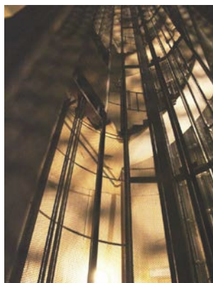
Betongkjernen med trapp og heis plassert i midten
