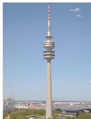
Olymiaturn, 1968 München, Tyskland Dagens funksjoner er utstilling, restaurant og kringkastingstårn. 291m. (figur 5)
