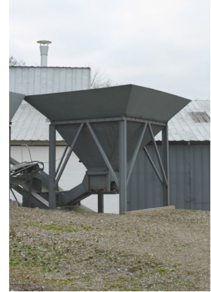
Silo, til transport af kalkrullesten, op til skaktovnen.
