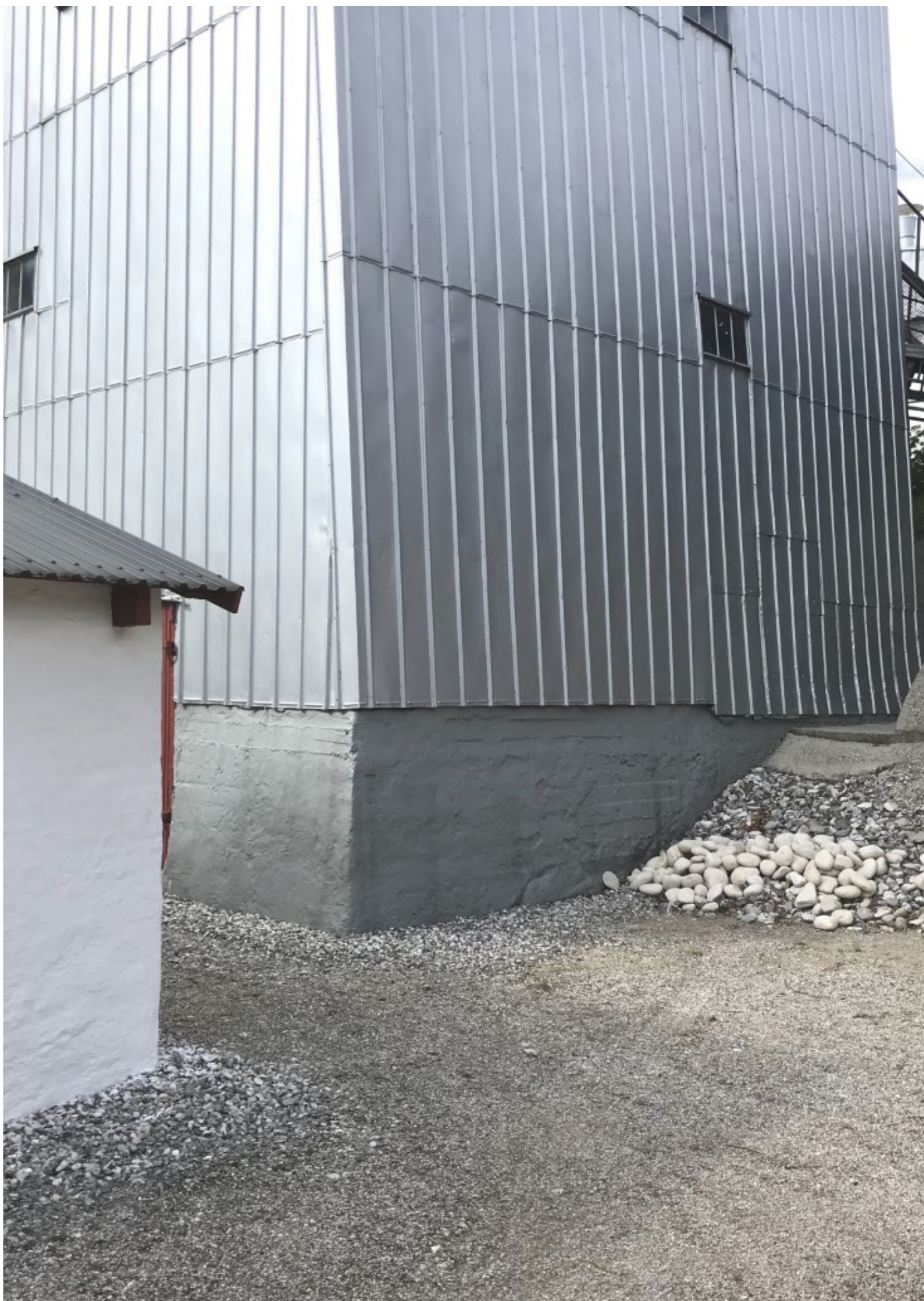
Hoed Kalkværk, kig mod silo og hjørnet af kalkladen.
