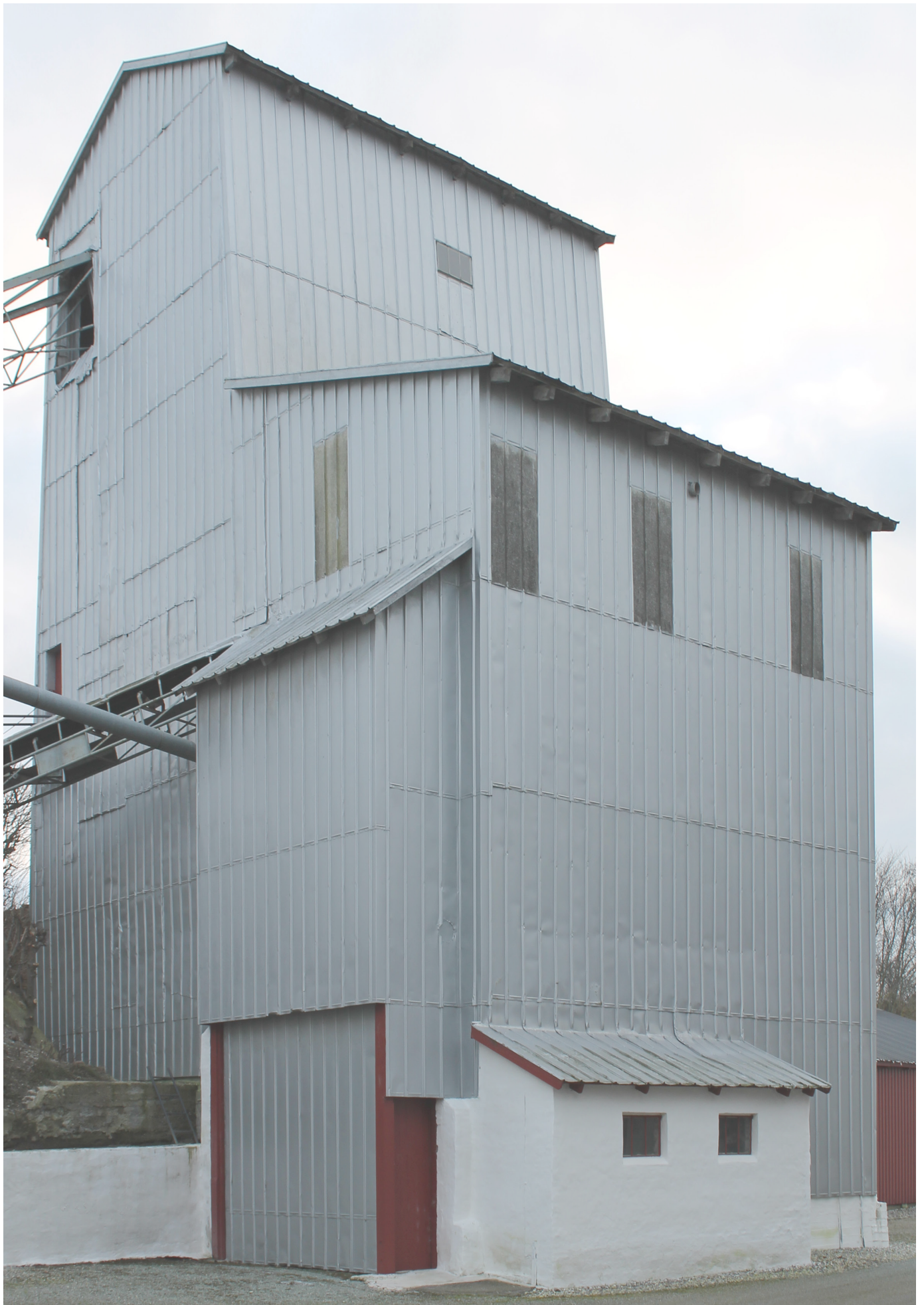
Hoed Kalkværk, den monolitiske silo.
