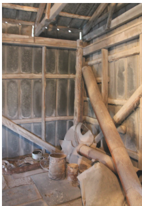
Synlige indvendige konstruktioner, ses på de fleste af bygningerne.
