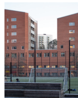
Seniorboliger og kommunal service Opført 1982
