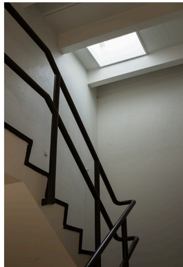
Ovenlys i tagdækelement, for hvilke de fleste er dækket til i forbindelse med additionen fra 1992.
