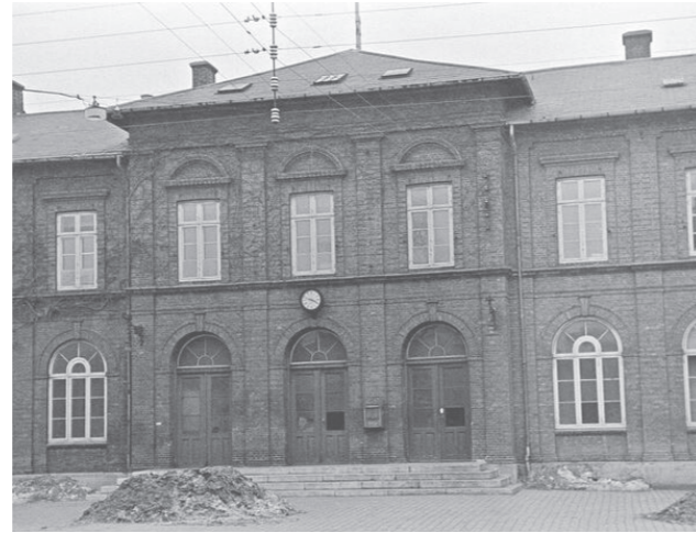
Stationsbygning på Vestre Stationsvej
