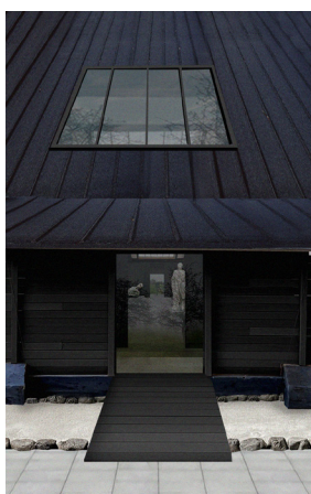
Overgang og åbning
