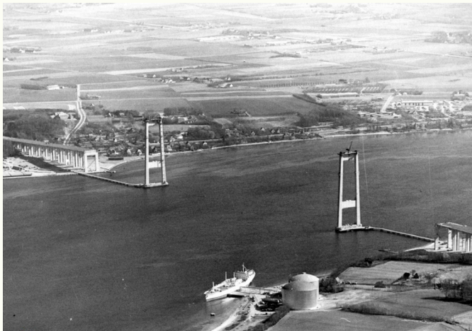
Construction of Den nye Lillebæltbro , 1986
