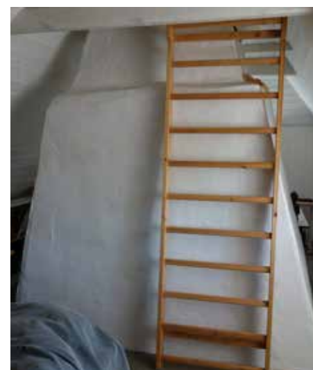
Den gamle skorsten på 1. sal i det østre stuehus.
