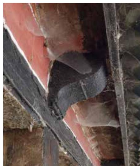
Profilerede bjælkeender på det vestre stuehus.
