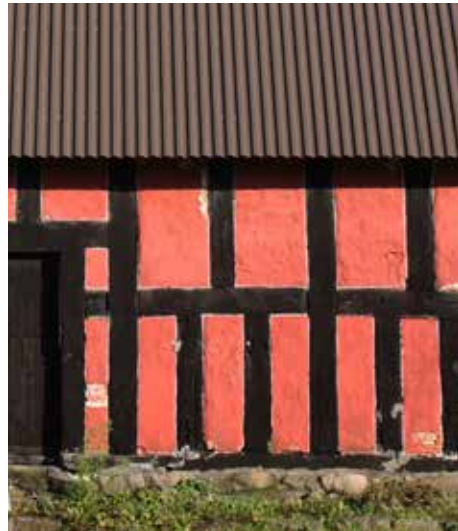
Vestre lade, sydfacade. Bindingsværk.
