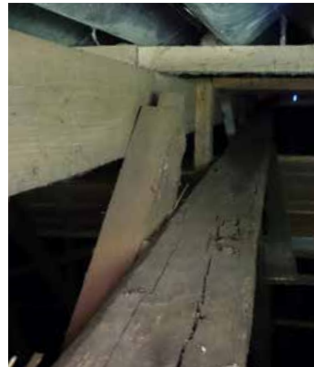
Kig op langs tagspær, med opklodset nyt spær ovenpå.
