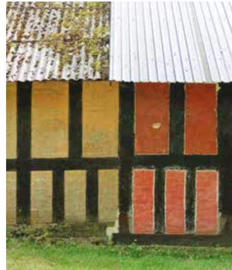
Overgang mellem laderne, nordfacade. Mur- + Bindingsværk.
