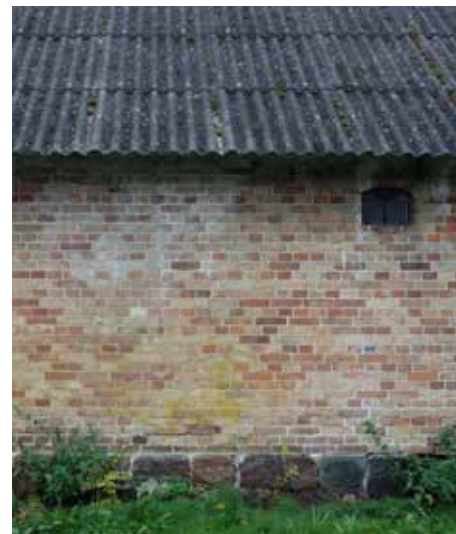
Midterlænge, østfacade. Murværk.
