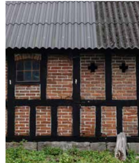
Midterlænge, vestfacade. Bindingsværk.
