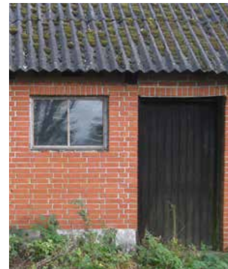
Vestre stald, vestfacade. Murværk.
