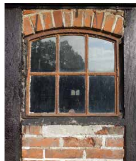
Staldvinduer i støbejern.
