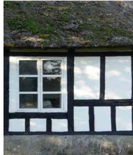
Østre stuehus, udskud på sydfacade. Bindingsværk.
