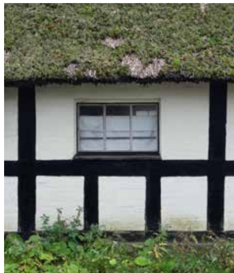
Østre stald, østfacade. Murværk.
