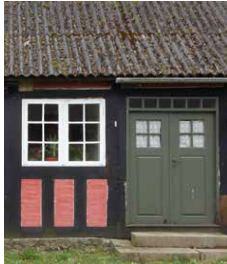
Vestre stuehus, nordfacade. Bindingsværk.
