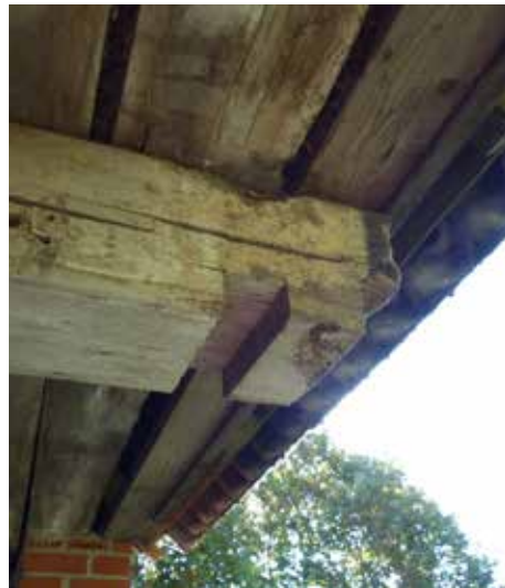
"Strittende" bindebjelke, der mangler sin søjle.
