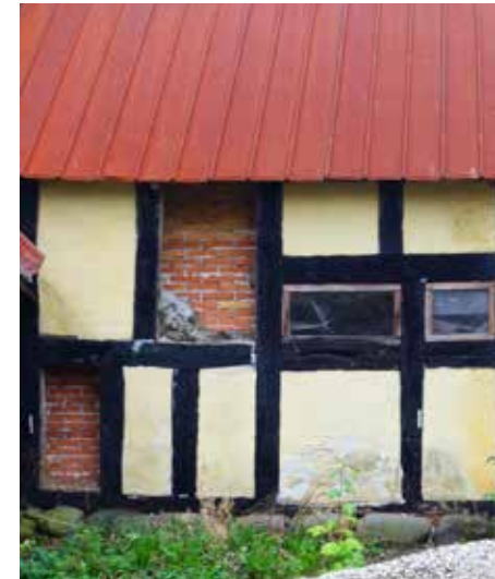
Østre lade, sydfacade. Bindingsværk.
