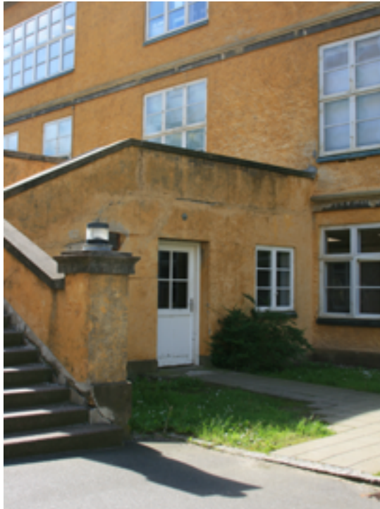
Det akisale forløb bliver brudt af et trappeforløb (bygning 3).
